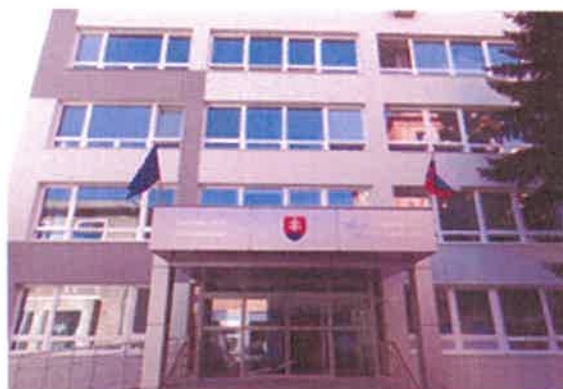
Obr. 2 - vchod do budovy okresného súdu
