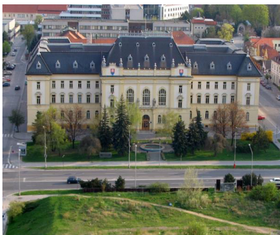
Obr. 1 – budova Okresného súdu Nitra
