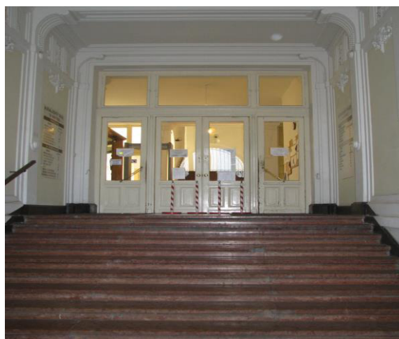
Obr. 2 – vchod do budovy okresného súdu
