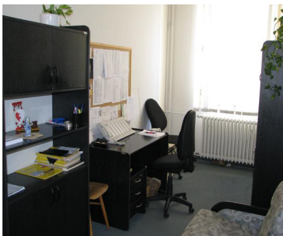
Obr. 5 – telefónna ústredňa okresného súdu
